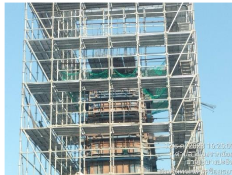
ภาพที่ 2.2-49 การติดตั้ง Safety Net
