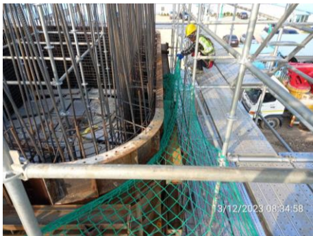
ภาพที่ 2.2-49 การติดตั้ง Safety Net
